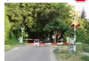
Automatizovano upravljanje uređajima za zatvaranje i otvaranje pružnog prelaza
