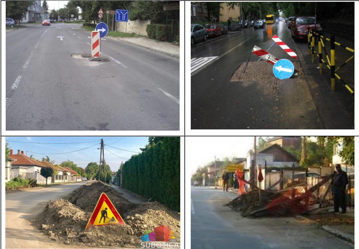
Slika 7. Tipični primeri nepravilnog obeležavanja radova na putu.
